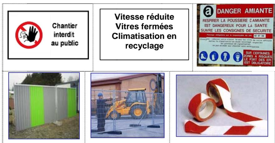
Exemples de balisage / clôture en entrée de zone de chantier amiante
