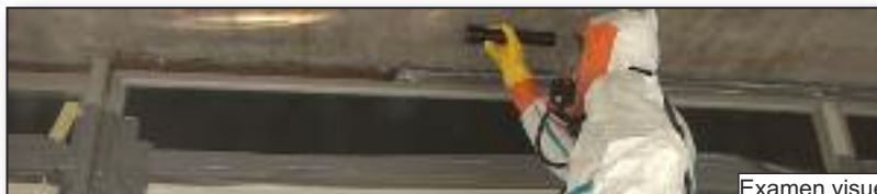
Examen visuel en fin de travaux
