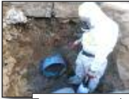
Travaux en zone de chantier amiante
