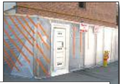
Delimitation zone chantier amiante/ zone chantier non amiante
